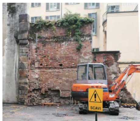
Fig. 1 - A sinistra, l’antico pilastrino ancora in loco, racchiuso da murature più recenti (febbraio 2010).
