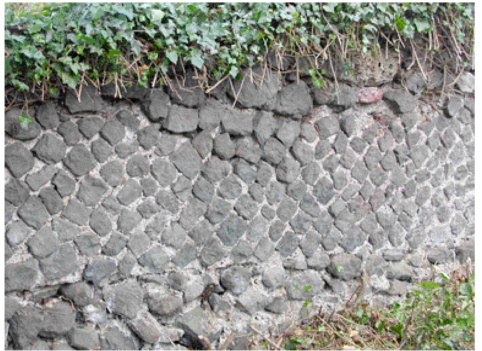
Tratto di muro in "opus reticulatum" di una villa romana nel territorio di Sovana. (Cortesia Soprintendenza per i Beni Archeologici della Toscana)
